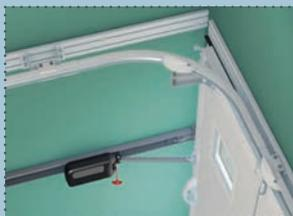
Guidage de la porte sur un rail, avec des double-galets montés sur roulement à billes pour un mouvement fluide et silencieux.
